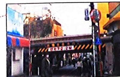
桁下の低い架道橋による緊急車両等の通行障害 東急東横線第一架道橋（桁下2.2m）
