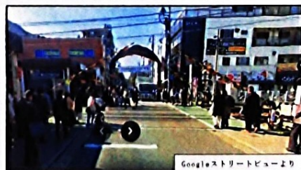
踏切による歩行者・自転車・自動車交通の遮断状況 (東急大井町線：尾山台1号踏切)
